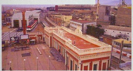
Instalaciones de NERTUS en Cornellá
